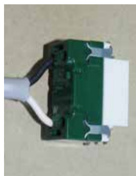
②写真に示す端子台の穴に銅線をまっすぐ入れ込み、 銅線が見えなくなるまで押し込む。
