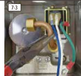
電磁弁を銅管ごと取り外す。 ※電磁弁内に溜まっていた水が流れ出ますので、タオルでよく拭き取ってください。
