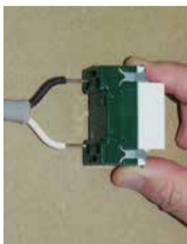
②写真に示す端子台の穴に銅線をまっすぐ入れ込み、 銅線が見えなくなるまで押し込む。
