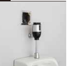
本体をバルブにねじ込み、アンダーカバーを装着する。
