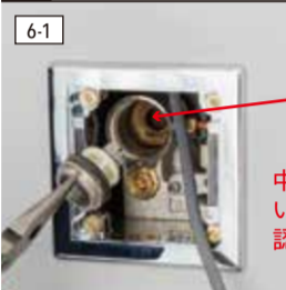
ピストンバルブと中に残った部品を全て取り外す。
