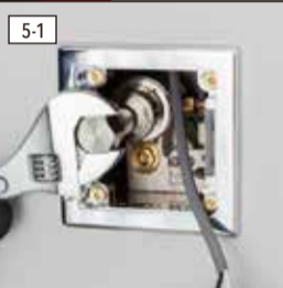
開閉工具をフタの溝に差し込み、スパナ等の工具を使用して回す。
