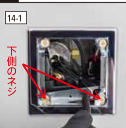
壁内の下側2か所のネジ裏の枠に、内側から配線固定金具を引っ掛ける。
