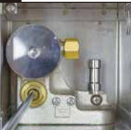
壁内の止水栓(開閉ネジ)を開ける。 ※通水経路で漏水がないか確認してください。
