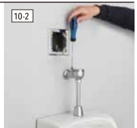
止水栓が閉まっているか確認する。
