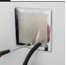
枠にパネルが均等に収まってから、付属のネジでパネルと配線固定金具を固定させる。
