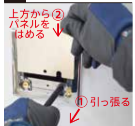
チューブを引っ張った状態で、パネルの切り込み溝にチューブの凹部を差し込み、パネルをはめる。
