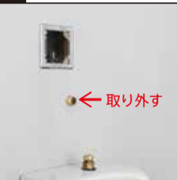
既設の洗浄管と壁側のニップルを取り外す。小便スパットはそのまま使用する。
