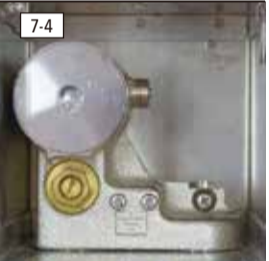
電磁弁撤去後の状態
