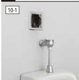
専用バルブを取り付ける。
