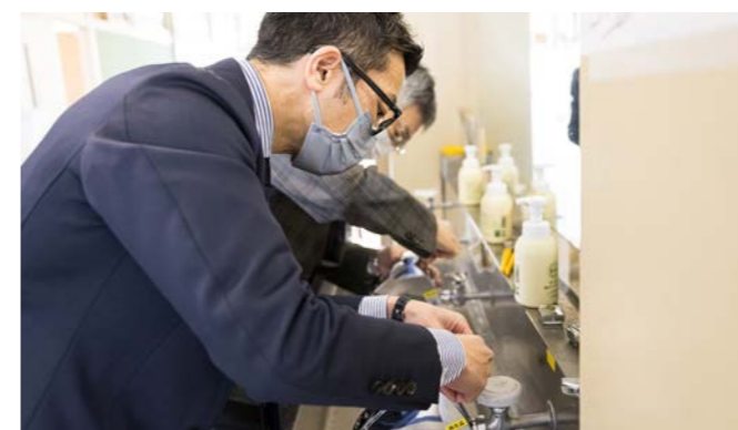
後付け式の自動水栓を設置する様子。5分足らずで取り付けが完了
