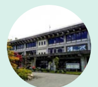
多賀町有施設
