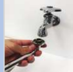
①既設水栓の パイプを取る
