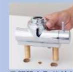
①既設を取り外し、 水栓下部を取付
