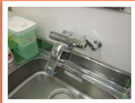
ナースステーション 現場写真
