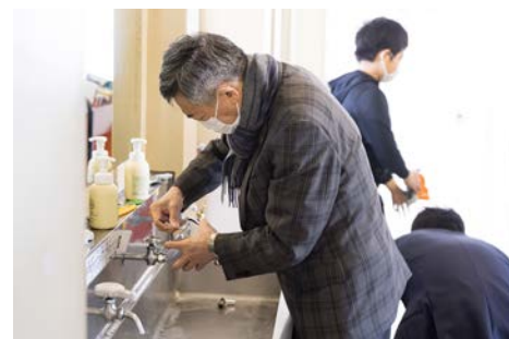
後付けで自動水栓を設置している様子
