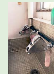
廊下の手洗い場の蛇口を自動化
