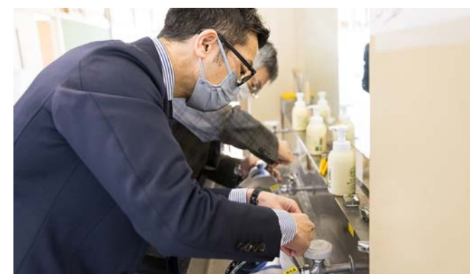
後付け式の自動水栓を設置する様子。5分足らずで取り付けが完了
